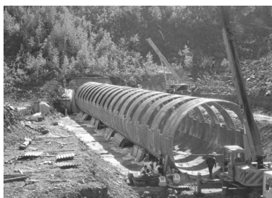
Рисунок 3 – Сборка МГК и схема восстановления разрушенного пролетного строения с использованием металлических гофрированных конструкций (по материалам [4])
