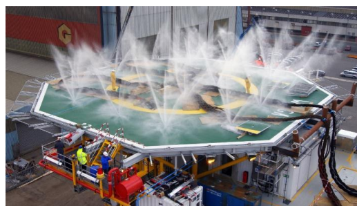
Рисунок 2 – Испытание системы пожаротушения вертолётной площадки со всплывающими насадами
