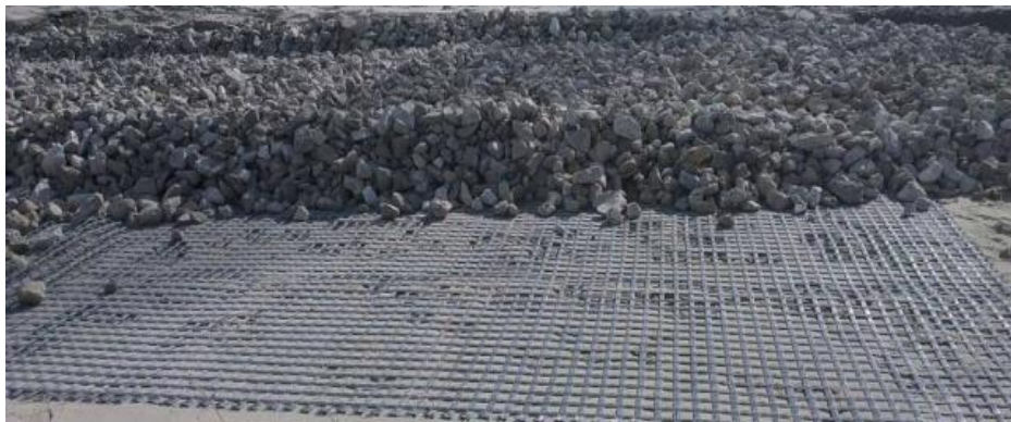
Рисунок 1 – Использование дорожной сетки при укладке асфальтобетонного покрытия
