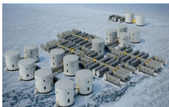
Рисунок 2 – Объекты в АЗ и на Крайнем Севере, выполненные на основе теплоизолированных модулей
